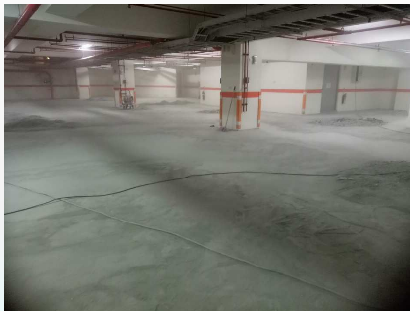
地下室停車場施工(預定近日完工)
