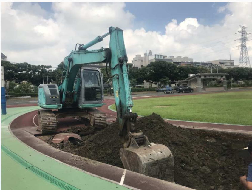
運動場跑道施工(預定9.26完工)
